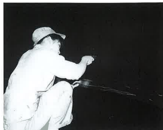
ゴム貼工程 ゴムシート貼付作業は、所定の厚さに調整したゴムシートを必要寸法に裁断し、ハンドローラーで圧着します。
