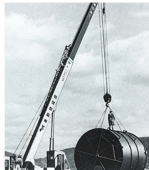
大型塩酸タンクの積出し(防府港)
