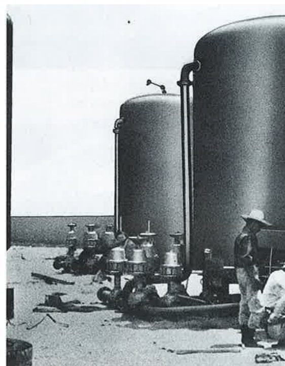
イオン交換純水装置の組付、水張りテスト
